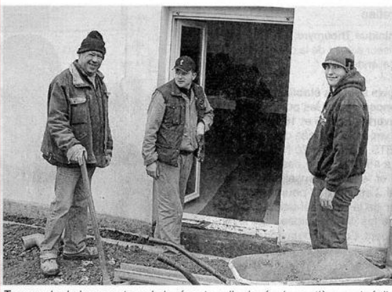
Travaux de drainage autour de la récente salle de réunion entièrement réalisée par des bénévoles.
