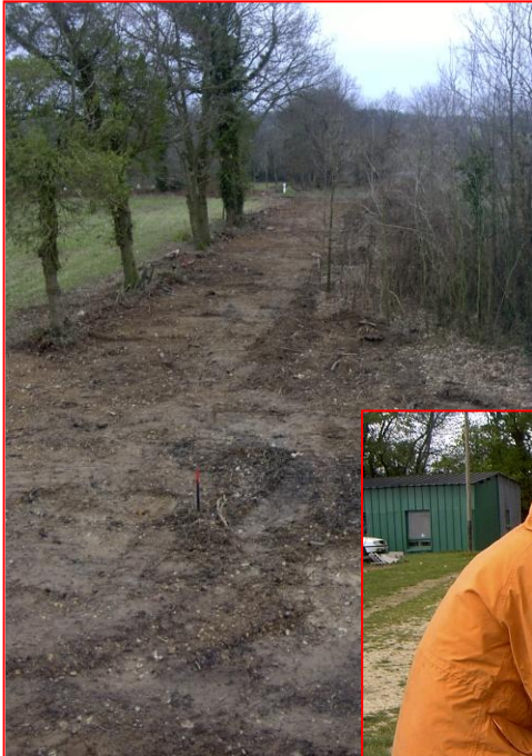
Création d'un chemin d'accès au terrain
